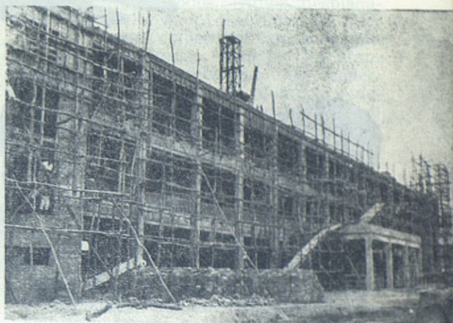
KWANGJU (Corea).—Estado de las obras de las Escuelas Salesianas en julio p. pdo., hoy ya casi terminadas.
