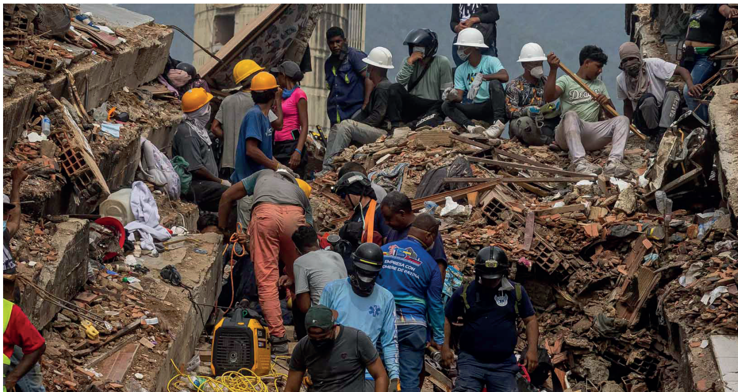
Rescatistas trabajando en los escombros de edificios por el terremoto en Venezuela.
