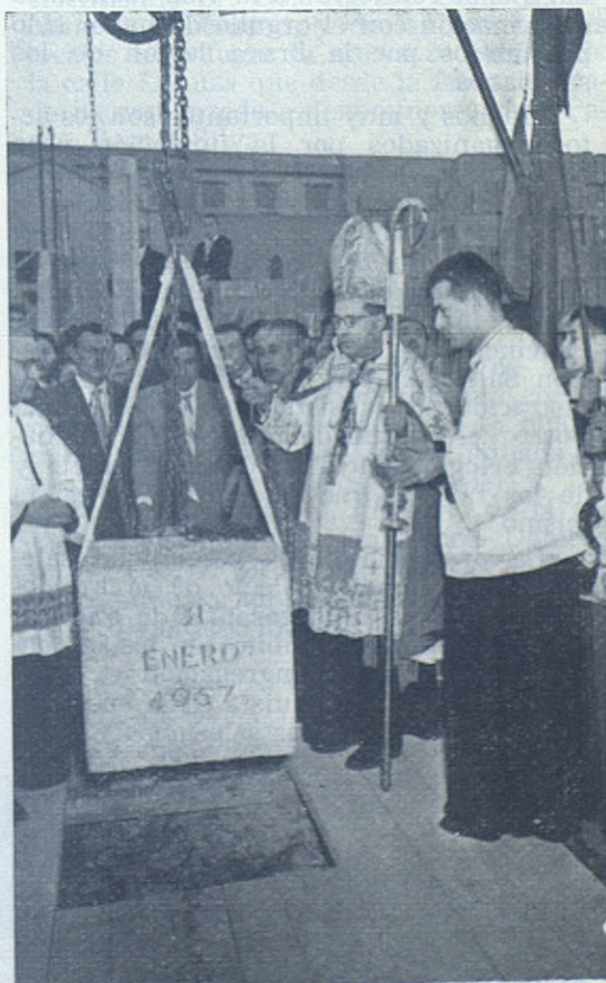
BARCELONA (Sarriá).—Bendición de la primera piedra del nuevo pabellón.
