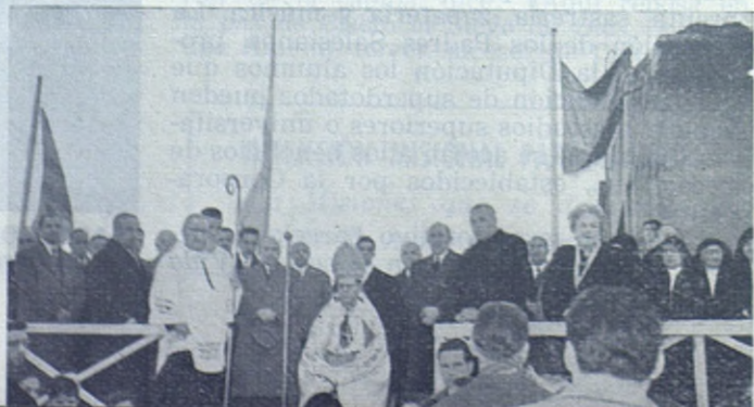
BARCELONA (Sarriá). — El Muy Rvdo. P. Inspector, Don Tomás Baraut, pronunciando unas palabras en el acto de la colocación de la primera piedra.
