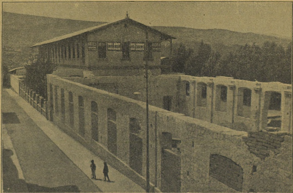
La Paz (Bolivia) — Colegio "Don Bosco" con la nueva iglesia en construcción.
