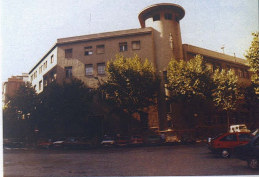
Interior de la iglesia y fachada exterior del colegio, que contará para este año con las instalaciones de una piscina cubierta, un polideportivo cubierto, un polideportivo al aire libre, doce pistas de squash y dos pisos de aparcamientos.
