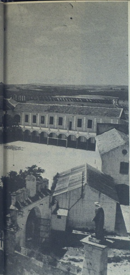
Vista panorámica del Colegio, como era antes...
