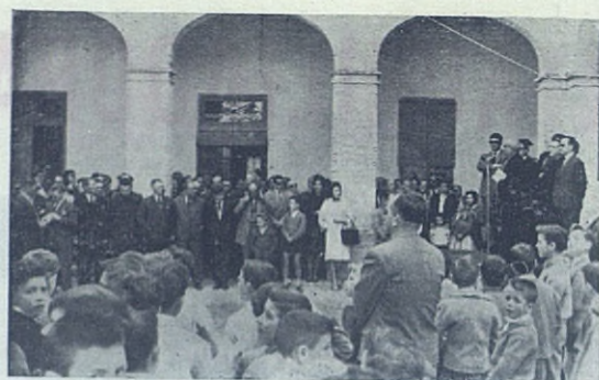
VILLENA.—Autoridades y público se congregaron en el Colegio Salesiano para celebrar el rápido progreso de las obras de ampliación.
