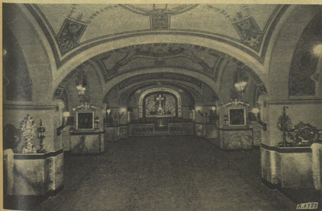
Nave y altar mayor de la Capilla
