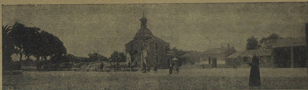
Campello (Alicante).—Estado en que la Revolución dejó la antigua iglesia de aquella Casa de Formación
