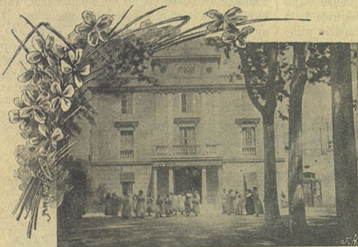
Fachada principal del Colegio Sta. Dorotea.
