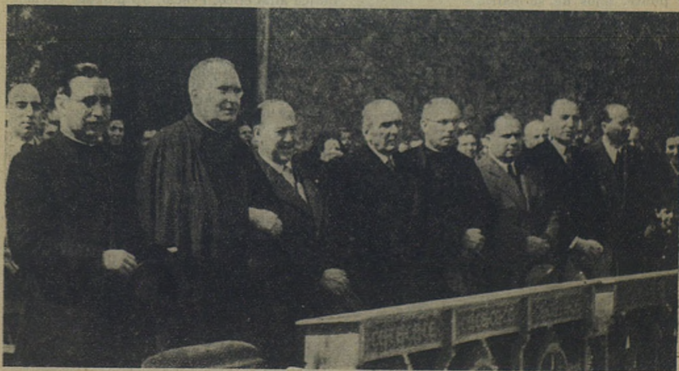
BARCELONA: Autoridades que asistieron al acto de la colocación de la primera piedra de la iglesia salesiana.
